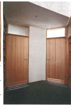
左：ルーバルコニーの内側には、丸太を挽いた状態のヒノキの耳付き板をファサードラタンで張った 中：2階居室のクローゼット内の床に設置したパイプ用ファン。電圧コントローラーで風量やモーター音を調節できる 右：居室のドアは、空気（暖気や冷気）の流れを考慮し、上部に開口、下部にルーバーを設けてある
