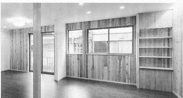
両端のMNパネルの間は窓をくり抜いて残った部位を現している
