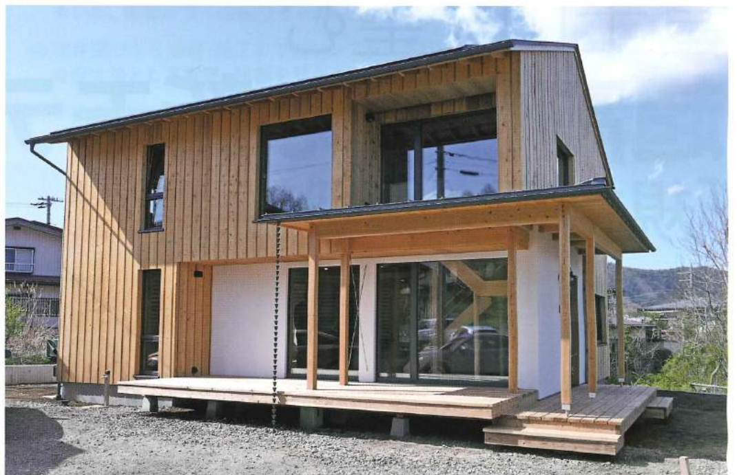
天野保建築の超高性能な新モデルハウス「木の窓から富士を眺める家」の外観。敷目板張りの八溝材のスギ板は無塗装。全開口部に用いた高性能木製サッシは、外側にサッシの枠が見えない納まりで、性能だけでなくデザイン的なメリットも大きい
