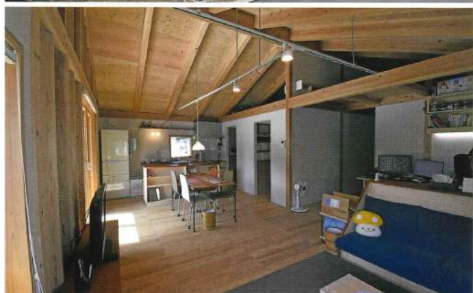
規格型住宅のモデルハウスとして活用するオーナー邸。外壁は透湿防水シートの上にスギ板をファサードラタンに張ったシンプルな仕上げ。コンパクトでシンプルなつくりすることで、コストを抑えながら高い性能を実現している
