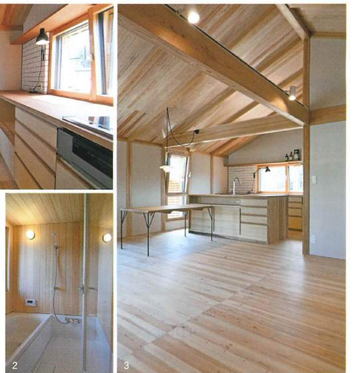
1.キッチンなど家具は大工が造作。大型パネルの導入により大工の仕事を、体力を主体とする単純作業から発想力・技術力を要するクリエイティブな仕事にシフトしている 2.ハーフユニットの浴室(2階)。ここにも木製サッシを用いている 3.内装用モイスと無垢の木材に囲まれた真壁の空間(2階LDK)
