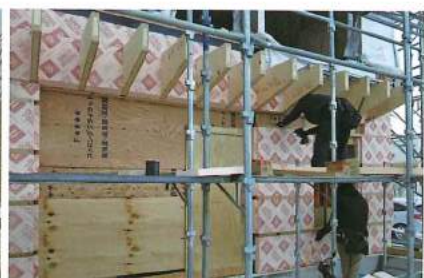
ボード型断熱材を用いた付加断熱で「断熱欠損や防湿の不安がなくなるので、(施工精度が重要といわれる)グラスウールの充填断熱でも安心できる」(菊池さん)。青森むつパッシブハウスでは、庇部分ははしご状の部材を取り付け、その内側にも断熱材を充填して合板でサンドイッチし、熱橋を極限まで減らした(右)
