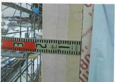
青森むつパッシブハウスの付加断熱。標準仕様の1.5~2倍の厚み(105mm+60mm)だ
