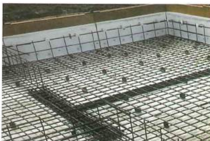
基礎断熱(左)は、底板下に敷く断熱材の厚みを利用し、地中梁の施工を合理化する工夫も。床断熱(右)は床上付加断熱が標準だ
