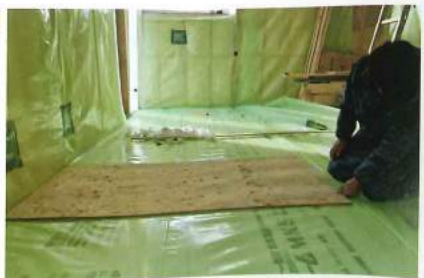
基礎断熱(左)は、底板下に敷く断熱材の厚みを利用し、地中梁の施工を合理化する工夫も。床断熱(右)は床上付加断熱が標準だ
