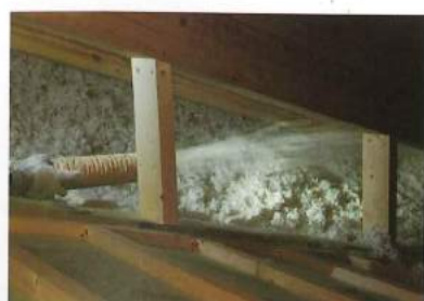
天井断熱はロックウールをブローイングで施工
