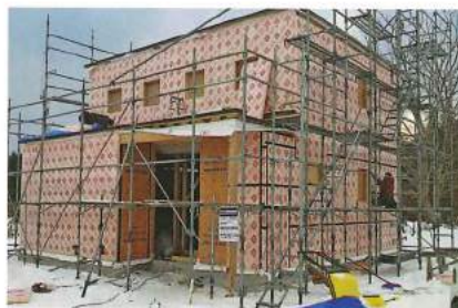
ボード型断熱材を用いた付加断熱で「断熱欠損や防湿の不安がなくなるので、(施工精度が重要といわれる)グラスウールの充填断熱でも安心できる」(菊池さん)。青森むつパッシブハウスでは、庇部分ははしご状の部材を取り付け、その内側にも断熱材を充填して合板でサンドイッチし、熱橋を極限まで減らした(右)
