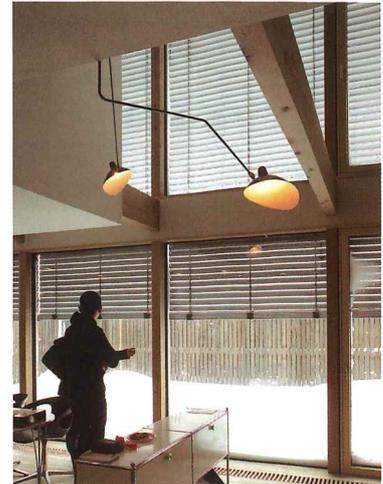
スマートウィン+ECLAZによる大開口。造作FIXとドレーキップを組み合わせている
