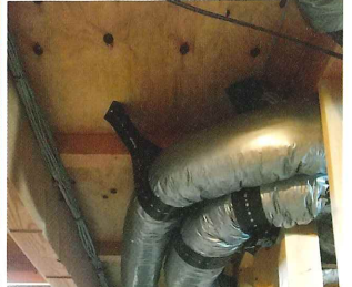
中/「Zehnder コンフォホーム」全体像。W1,350×D880×H300の本体を納めるには、約1.5坪以上のスペースが必要である
