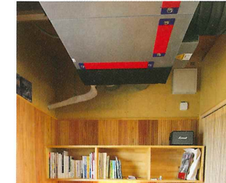
左/1階ウォーククロゼット兼書斎。天井に全館換気空調システム「Zehnder コンフォホーム」を設置。メンテナンス用にあえて天井
