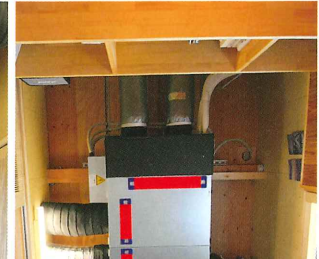
井は仕上げていない 右/ダクトルートを確保するため、廊下の天井高は2,150mmになっている
