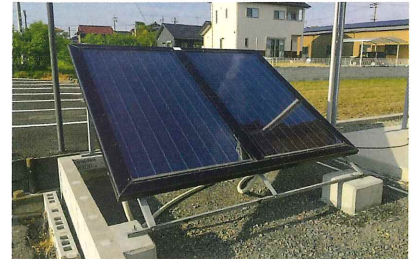
玄関前に30度の勾配を付けた給湯用太陽熱集熱パネルを設置
