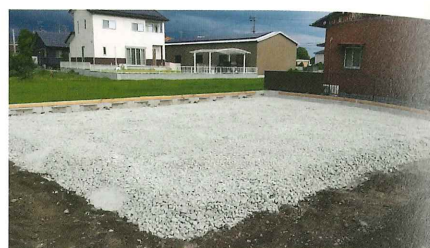
1 土地の造成後、リサイクル発泡ガラス砕石を200mm厚で敷いた状態
