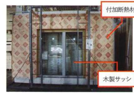
付加断熱と木製サッシは大型パネルに組み込んだ。外壁板張りに大工の手が取られる部分を吸収できる
